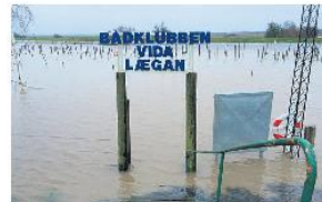
Forhøjede og forvandede vandstande omkring pumpestationen Lægån er styret realistisk scenarie. Billedet er fra efteråret 2015. Foto: Uwe Iwersen
